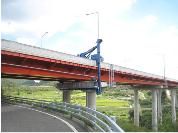
굴절차를 이용한 근접조사
