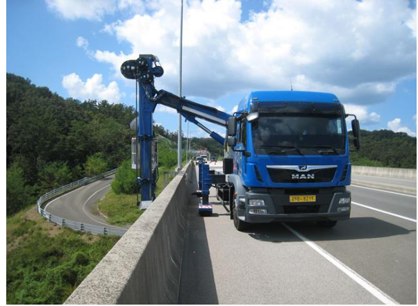
굴절차를 이용한 근접조사
